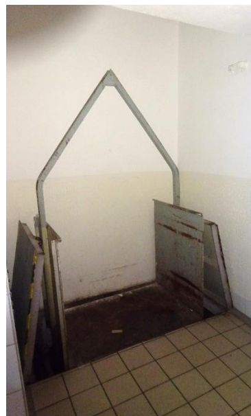
Obrázok 51 – Plošinový nákladný výťah
