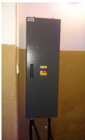
Obrázok 43 – Záložný zdroj Masterys GP4 s batériami a rozvádzačom
