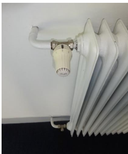
Obrázok 12 – Termostatická hlavica - detail
