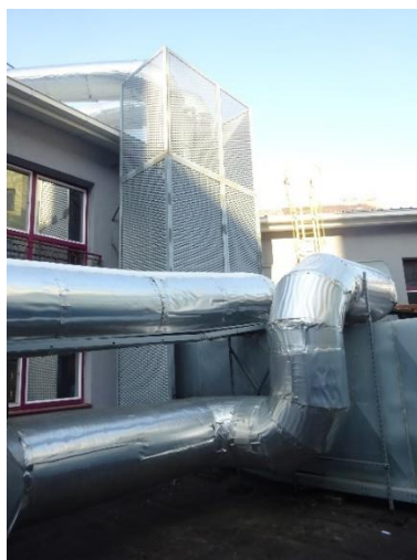
Obrázok 32 – Odvod odpadového vzduchu nad strechu kuchyne
