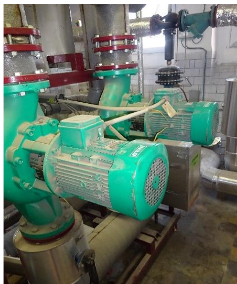
Obrázok 10 – Obehové čerpadlá ÚK
