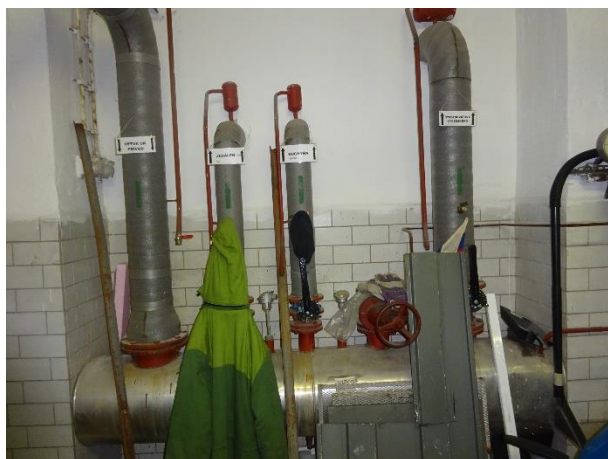
Obrázok 14 – Primárny rozdeľovač R1
