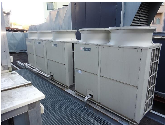
Obrázok 30 – Vonkajšie jednotky VRV systémov pre jedáleň
