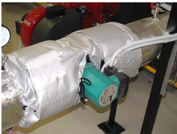
Obrázok 91 – Príklad zateplenia armatúr vykurovacej sústavy
