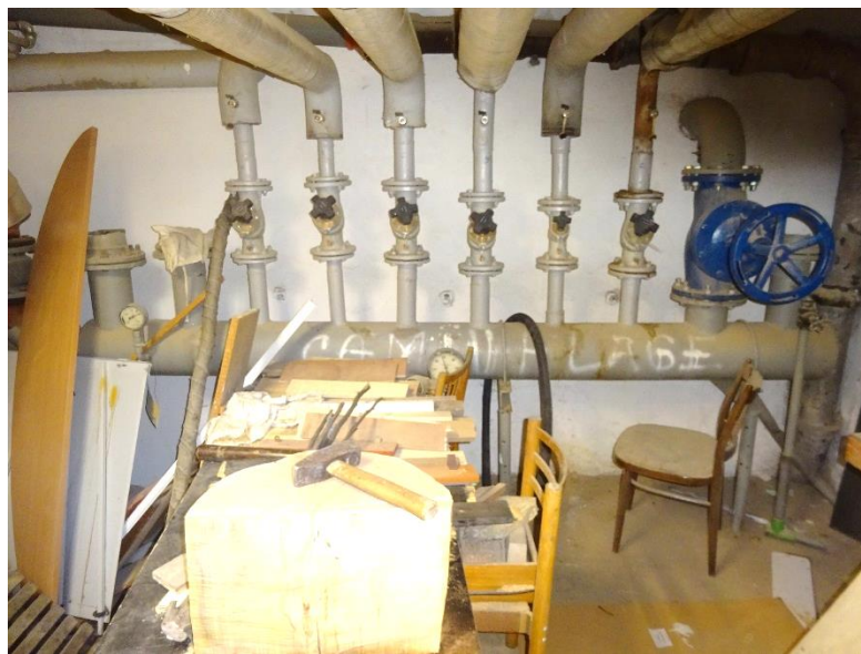
Obrázok 90 – Súčasný stav zateplenia armatúr vykurovacej sústavy
