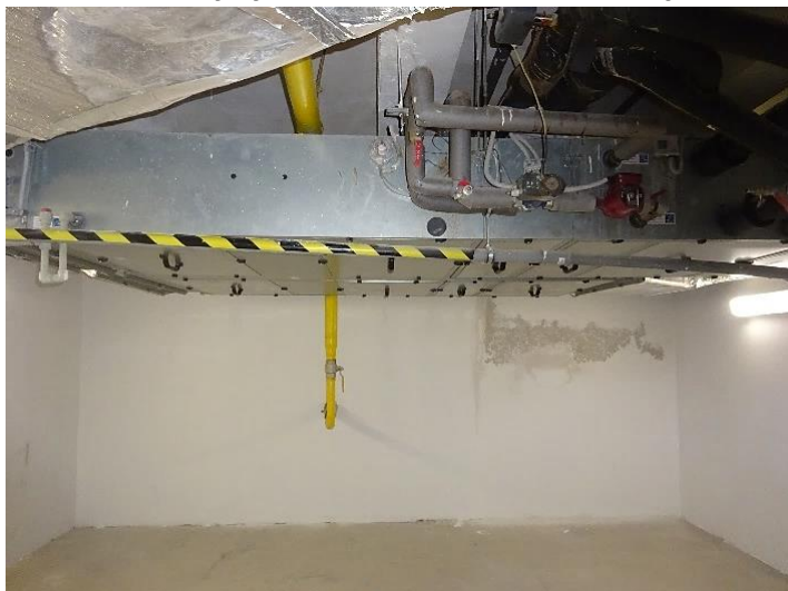
Obrázok 84 – Hlavný uzáver plynu
