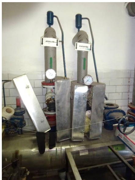
Obrázok 90 – Súčasný stav zateplenia armatúr vykurovacej sústavy
