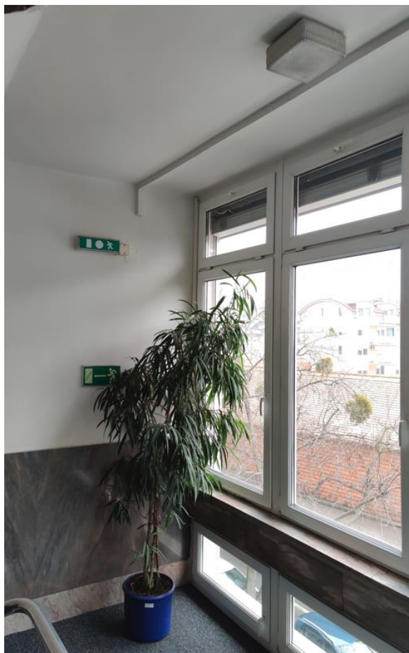
Obrázok 66 – Pohľad na žiarovkové svietidlo „Ž“ na schodisku – svietidlo nie je schopné zabezpečiť dostatočnú osvetlenosť
