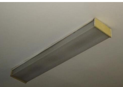
Obrázok 41 – Žiarivkové osvetlenie 2x36W na chodbách
