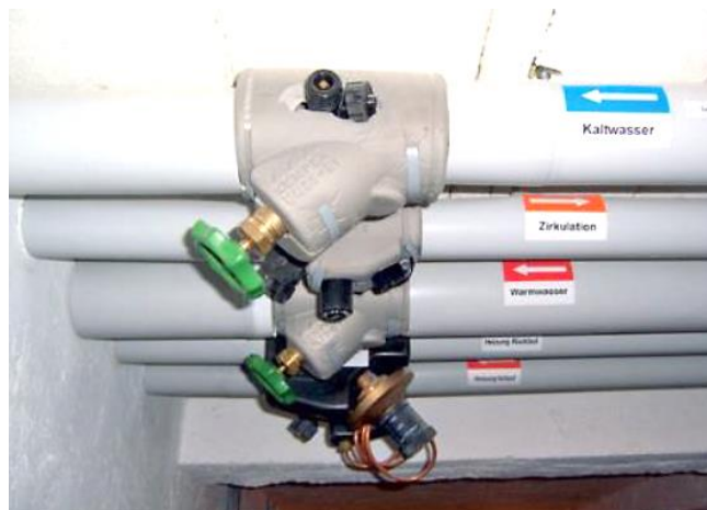
Obrázok 91 – Príklad zateplenia armatúr vykurovacej sústavy
