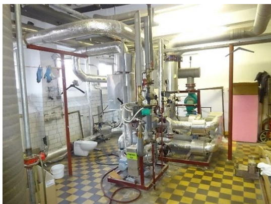
Obrázok 6 – Kompaktná stanica DECON
