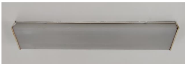
Obrázok 53 – Pohľad na svietidlá typu „B“ v prevedení 2x36W
