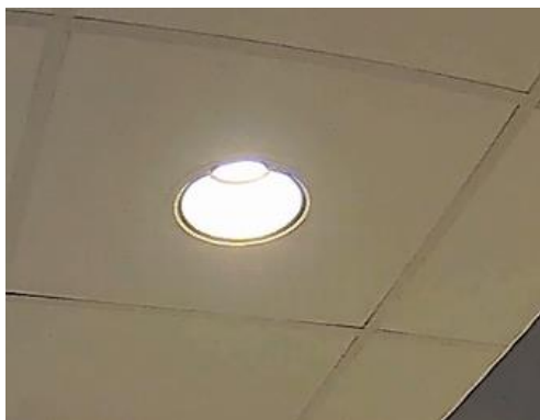
Obrázok 58 – Svietidlá „D4“ osadené v štruktúrovanom strope na soc. zariadení
