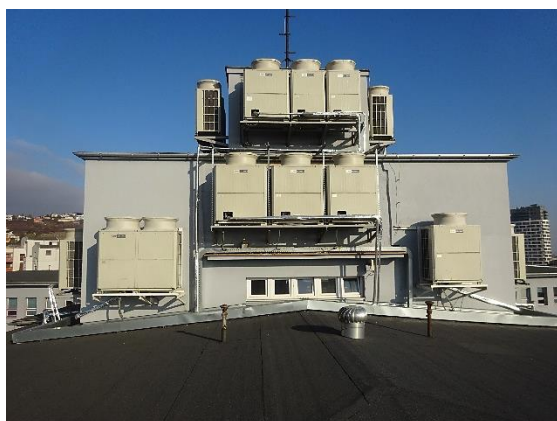
Obrázok 28 – Vonkajšie jednotky VRV systémov na objekte Štefanovičová
