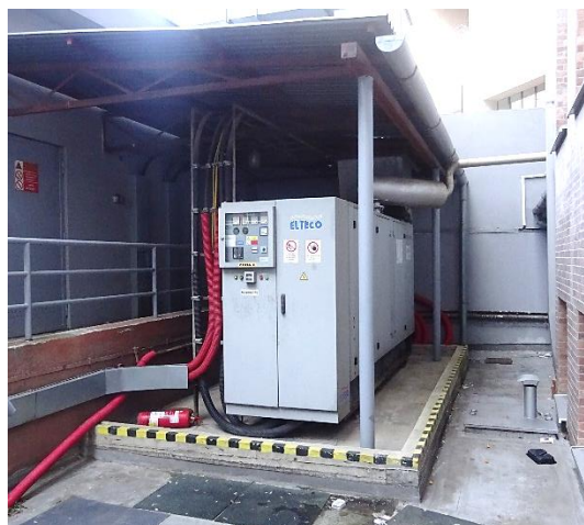
Obrázok 48 – Dieselagregát Elteco
