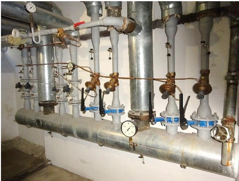
Obrázok 18 – Podružný rozdeľovač R3 a zberač Z3
