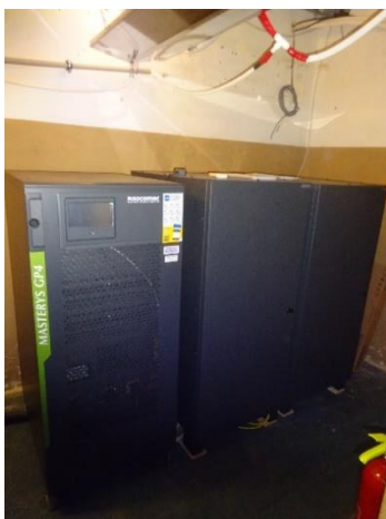
Obrázok 43 – Záložný zdroj Masterys GP4 s batériami a rozvádzačom
