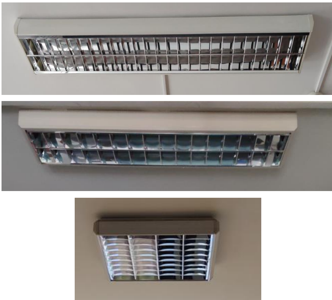
Obrázok 55 – Pohľad na svietidlá typu „C“ v prevedení 2x58W, 2x36W, 4x18W
