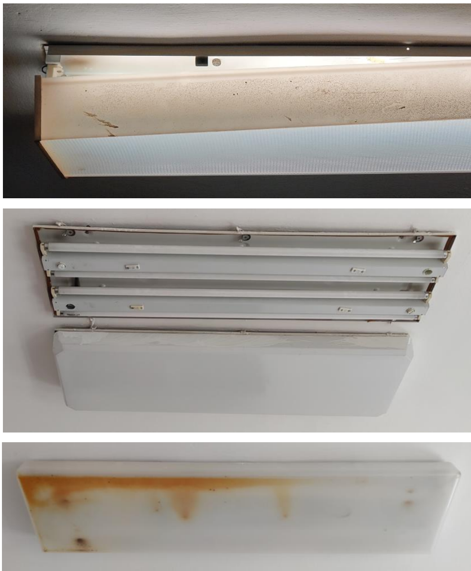
Obrázok 54 – Rôzne nedostatky svietidiel typu „A“ a „B“ (uvoľnený, chýbajúci, zatečený kryt)
