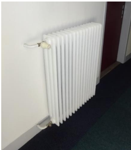
Obrázok 11 – Vykurovacie teleso s termostatickou hlavickou
