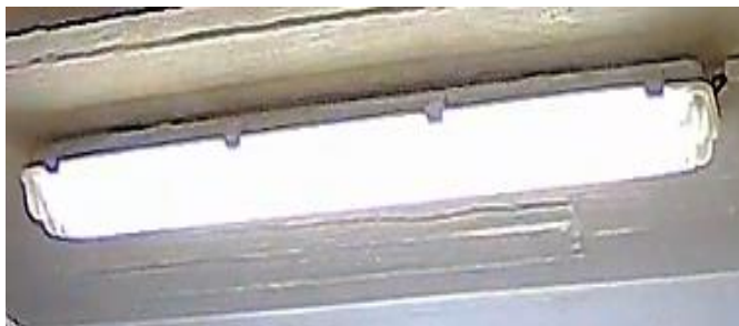
Obrázok 62 – Prachotesné svietidlo Typu „P1“ 2x36W
