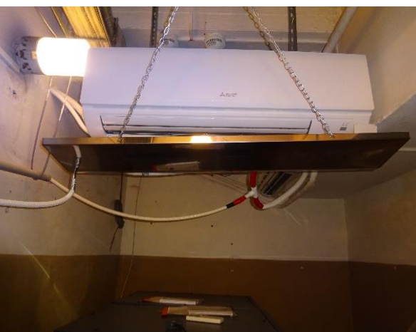
Obrázok 44 – Chladenie miestnosti UPS v suteréne SO1
