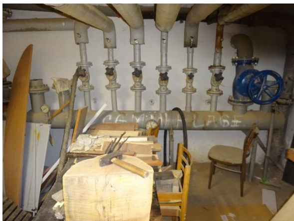
Obrázok 16 – Podružný rozdeľovač R2
