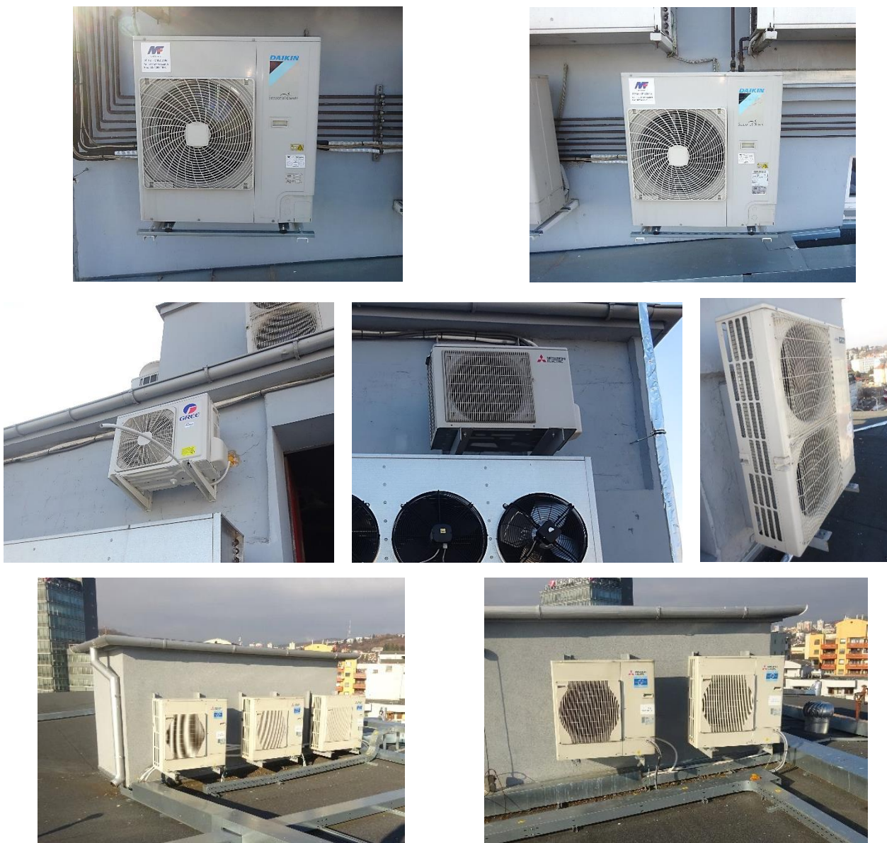
Obrázok 29 – Vonkajšie jednotky SPLIT systémov na objekte Štefanovičova
