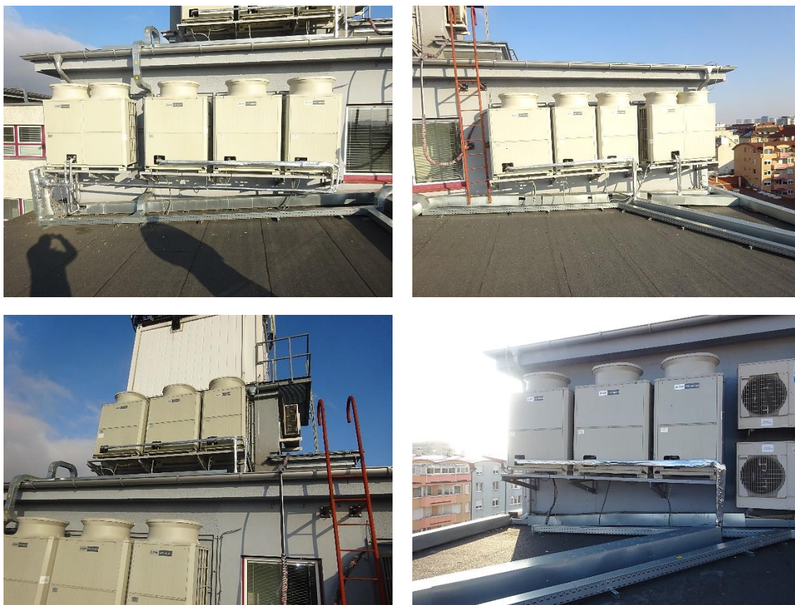
Obrázok 26 – Vonkajšie jednotky VRV systémov na objekte Kýčerského
