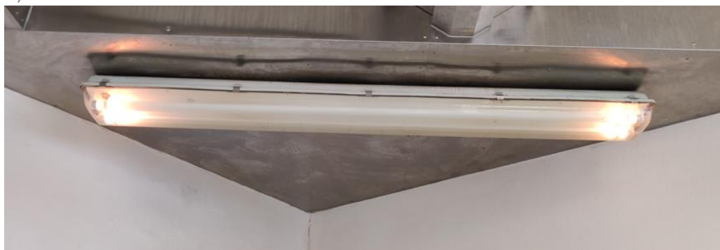
Obrázok 63 – Príklad svietidla, ktoré vlastne nesvieti a spotrebováva el. energiu v plnom príkone
