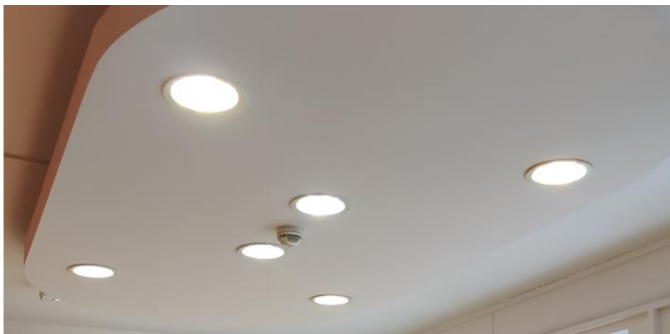
Obrázok 57 – Svietidlá „D3“ osadené v SDK stropnej konštrukcii
