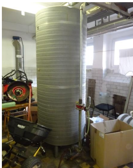
Obrázok 21 – Akumulačná nádoba TUV
