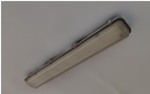
Obrázok 62 – Prachotesné svietidlo Typu „P1“ 2x36W
