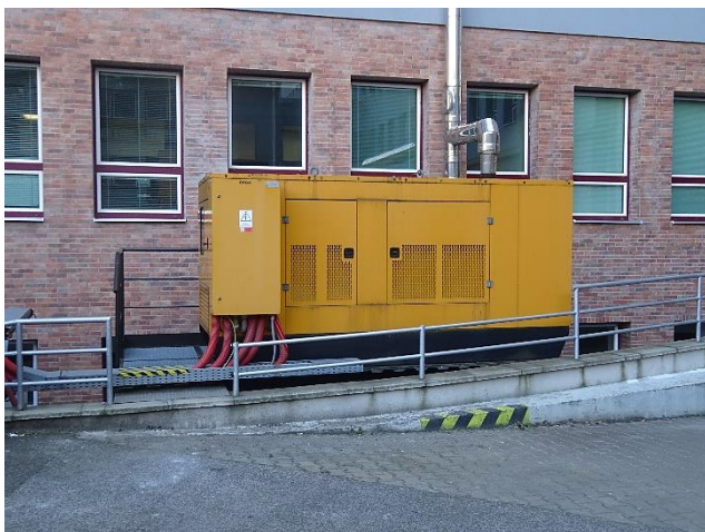
Obrázok 47 – Dieselagregát CAT-Zeppelin
