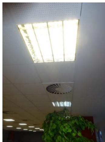
Obrázok 34 – Detail kruhového anemostatu v jedálni
