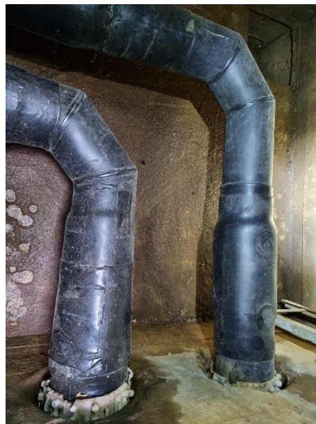
Obrázok 24 – Šachta horúcovodu RS1 (po oprave)
